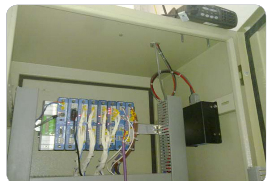
Automate TBOX et radio Motorola
